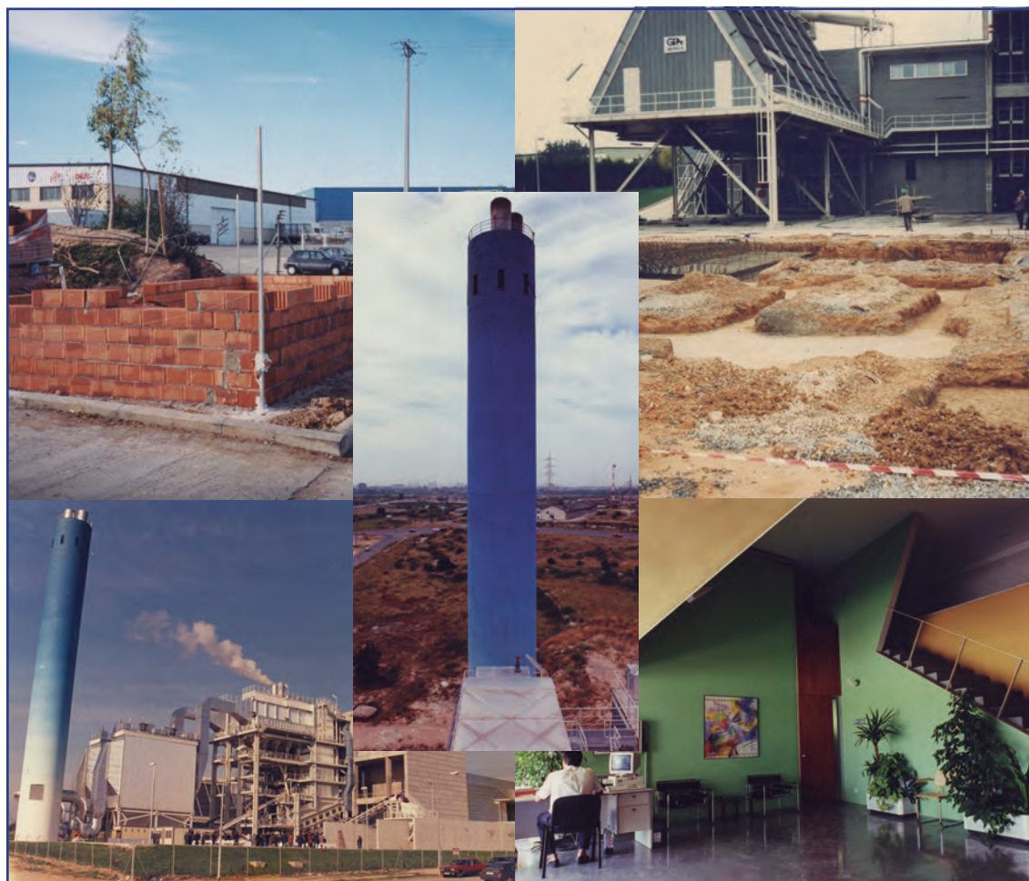
Diferents imatges de les primeres instal·lacions i les obres, un cop posada en marxa la planta, per millorar l'equipament, com la caseta de vigilància i control d'accessos
