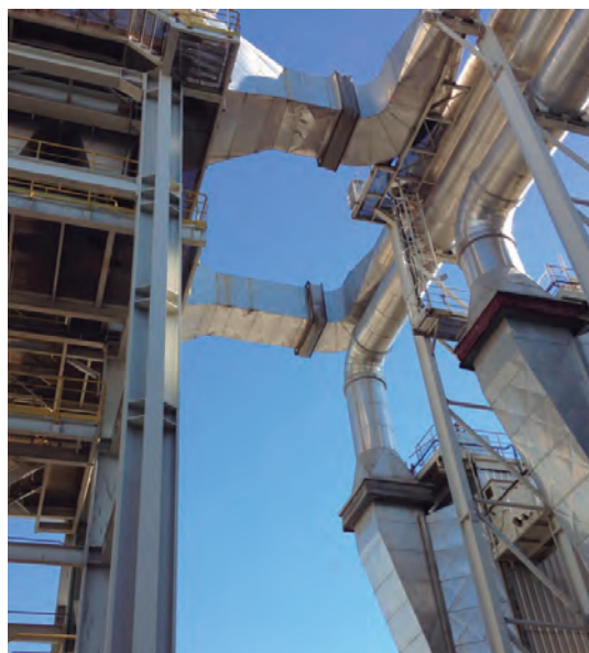
El cor de la planta: els forns i calderes, i les connexions amb els filtres de gasos, abans de passar a la xemeneia
