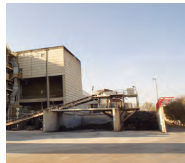
Indret on se separen ferralles de l'escòria, per reutilitzar-les
