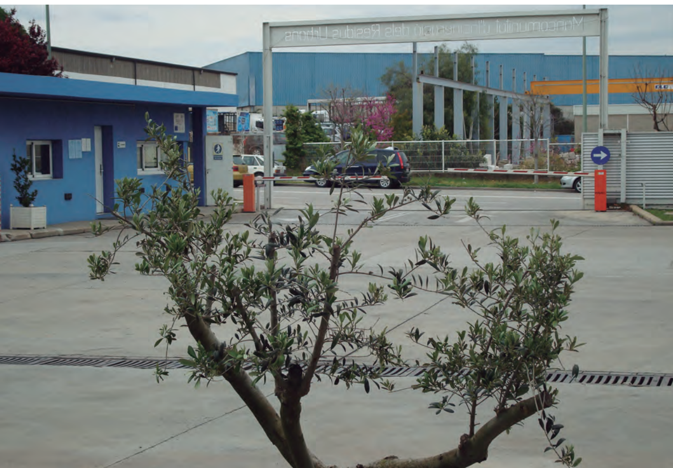
Vista de l'accés a la planta des de l'interior de SIRUSA
