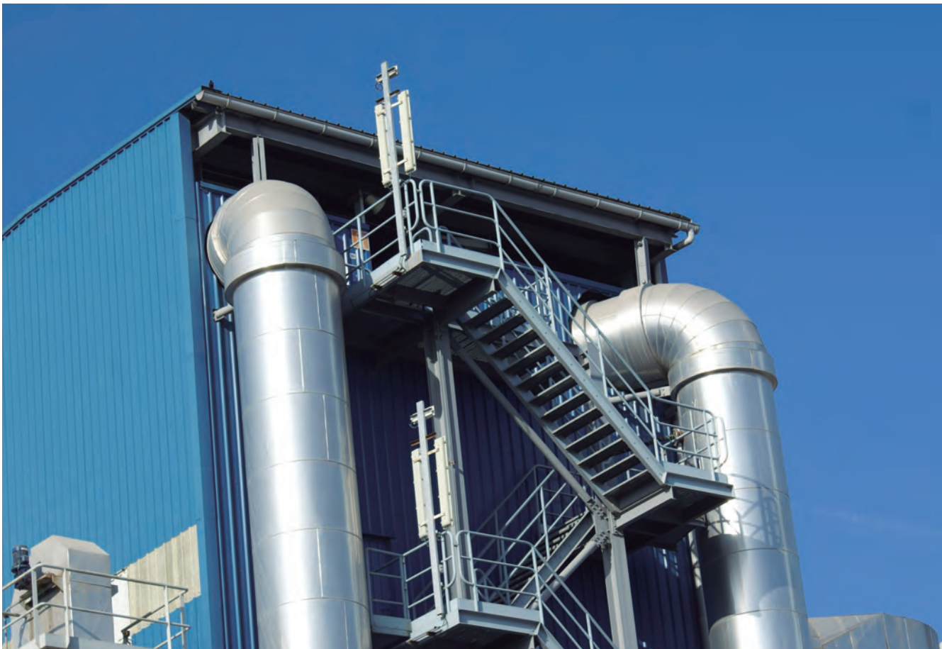
Detall de les conduccions de gasos als filtres, abans de sortir per la xemeneia
