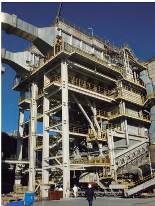
El cor de la planta: els forns i calderes, i les connexions amb els filtres de gasos, abans de passar a la xemeneia
